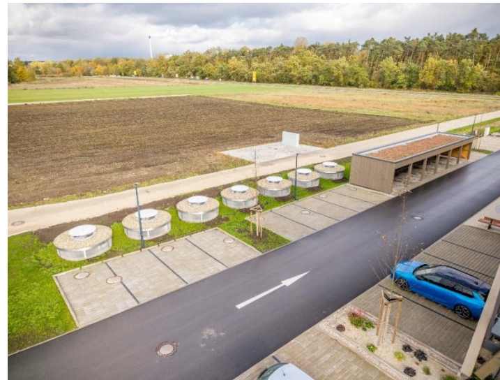
Kombimodule + unterirdische Eisspeicher in Parkplatzfläche
