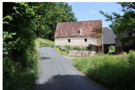
Anschluss ans Kanalnetz Ortsteil Breitenbrunn
