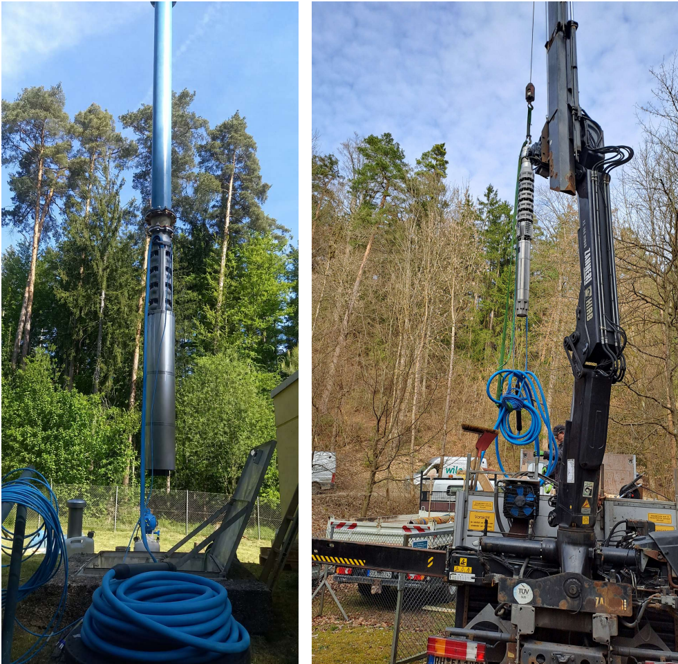
Erneuerung Brunnenpumpen Haselgraben
