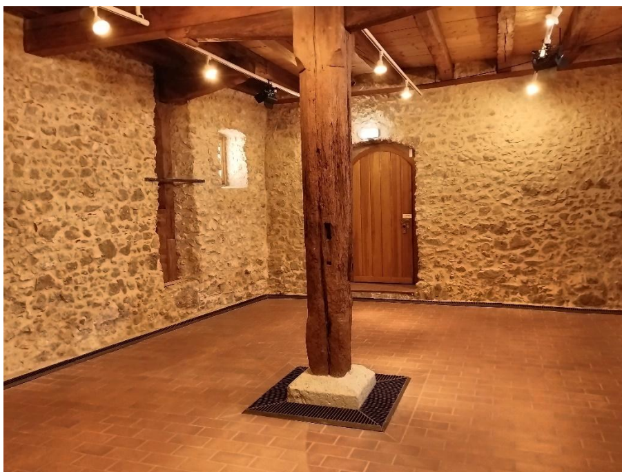
Fotografie des Raums mit Zugangstür nach außen (Anbringung einer Rampe für Barrierefreiheit erforderlich).
