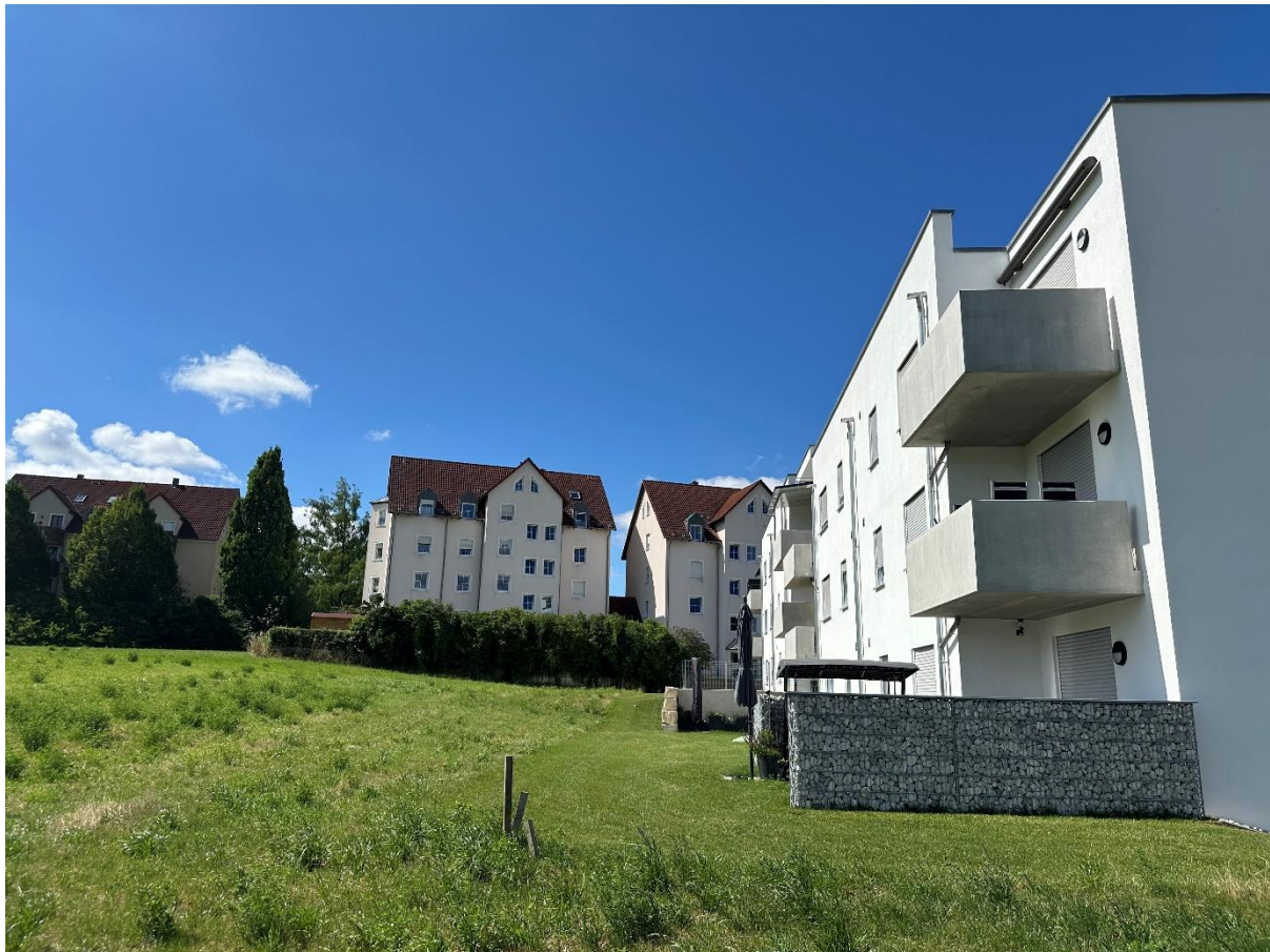
Abb. 1: Foto rechts Ostfassade der Anwesen Loderhofstraße 12 und 14, Mitte die südlich an das Plangebiet angrenzende Bebauung
